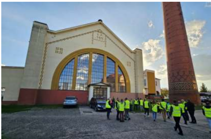
Obr. 2. Úpravňa vody Káraný
