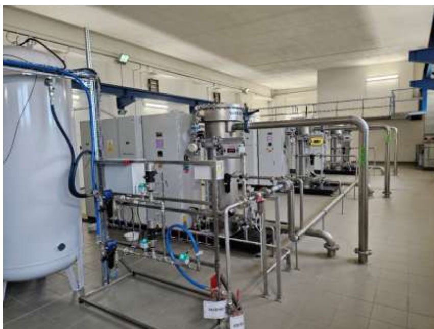
Obr. 4. ÚV Plzeň – výroba ozónu
