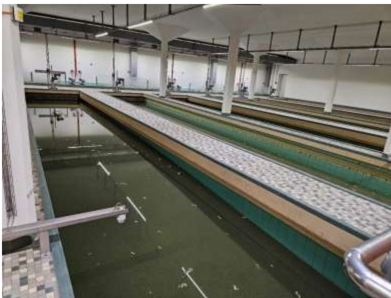
Obr. 5. Úpravňa vody Das Seewasserwerk Lengg – otvorené pieskové filtre
