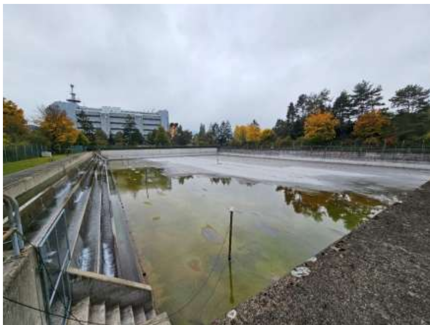
Obr. 7.: Úpravňa vody Das Grundwasserwerk Hardhof – infiltračná nádrž
