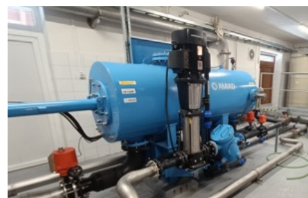
Pieskové filtre vľavo a mikrofiltrácia vpravo v ÚV Jasná
