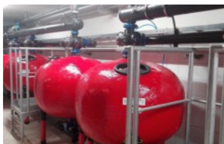
Pieskové filtre vľavo a mikrofiltrácia vpravo v ÚV Jasná
