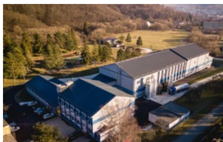
Pohľad na zrekonštruovanú budovu ÚV
