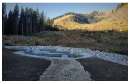
Záchyt vodárenského zdroja - Zadná voda po rekonštrukcii
