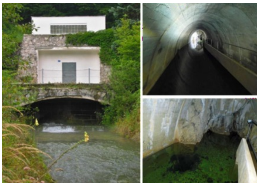
Zdrojový objekt nad prameňom, chodba vedúca k prameňu a miesto výveru
