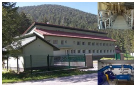
Budova úpravne vody v Demänovskej doline
