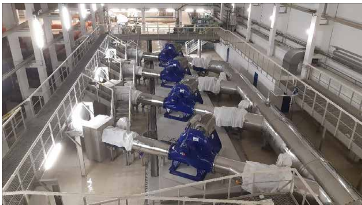
Čerpací stanice na GAU filtraci – čtveřice horizontálních čerpadel a sací řad s odbočkami k jednotlivým čerpadlům
