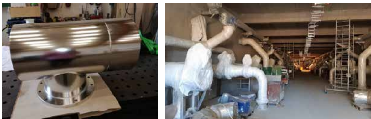
Obrázek 11: Referenční tvarovka s finální povrchovou úpravou; ochrana potrubí během stavby
