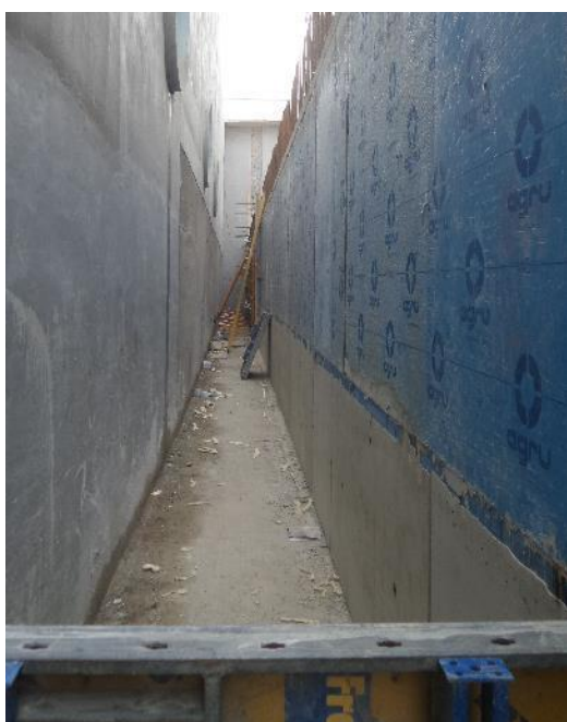
Obrázek 5: Vystýlka v rozdělovacím kanálu – 1. etapa po odbednění; finální extruzní svařování
