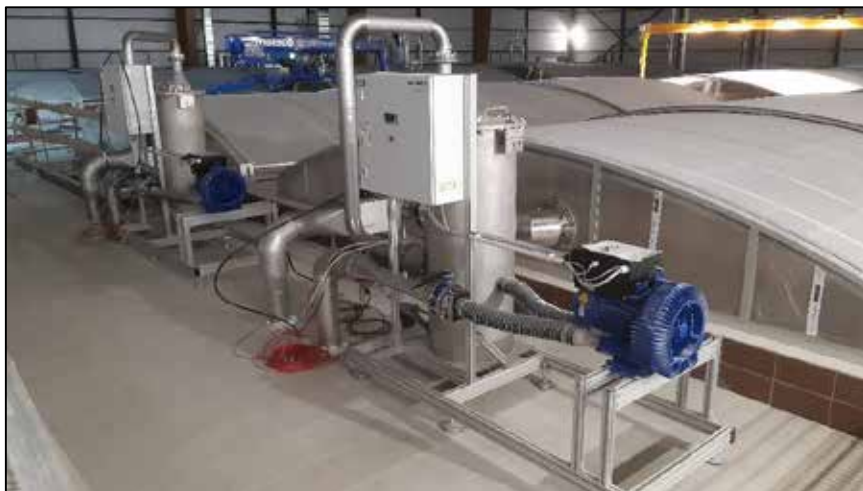
GAU filtrace - dvojice destrukturu pro odstranění ozónu ze vzduchu odvětrávaného z prostoru pod zakrytím filtrů
