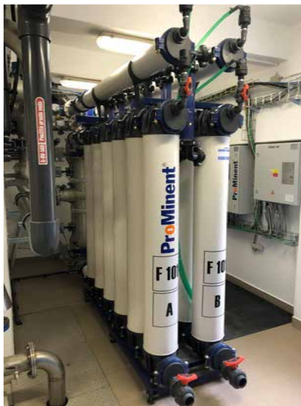
Paralelné pracujúce ultrafiltračné línie UF12.60
