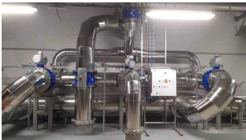
Obrázek 12: Pohled na čelo filtru po odstranění ochrany
