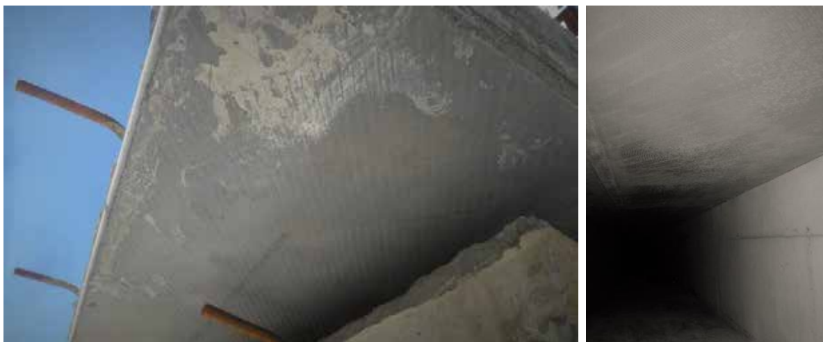
Obrázek 2: Panely pro zastropení kanálů ve Filtraci GAU – spodní líc na překládce; po uložení nad kanálem
