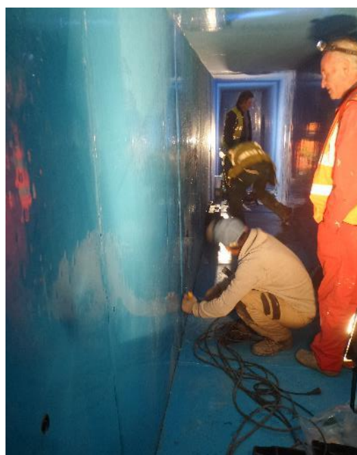
Obrázek 5: Vystýlka v rozdělovacím kanálu – 1. etapa po odbednění; finální extruzní svařování
