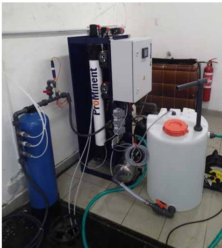
Zariadenie použité pri poloprevádzkovej skúške
