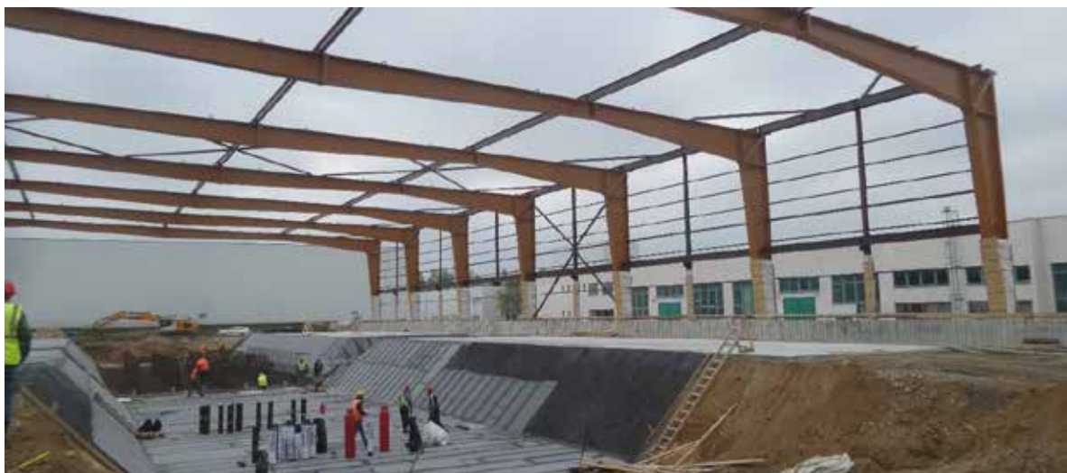
Obrázek 1: Úplná soustava hlavních rámu a práce pod nimi
