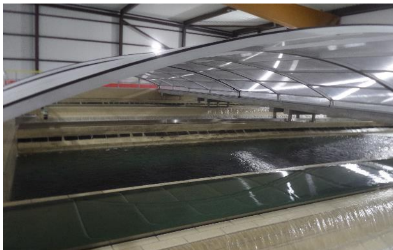
Obrázek 3: Zakrytí van filtrů. Detail ve výrobě; filtr v provozu pod zakrytím
