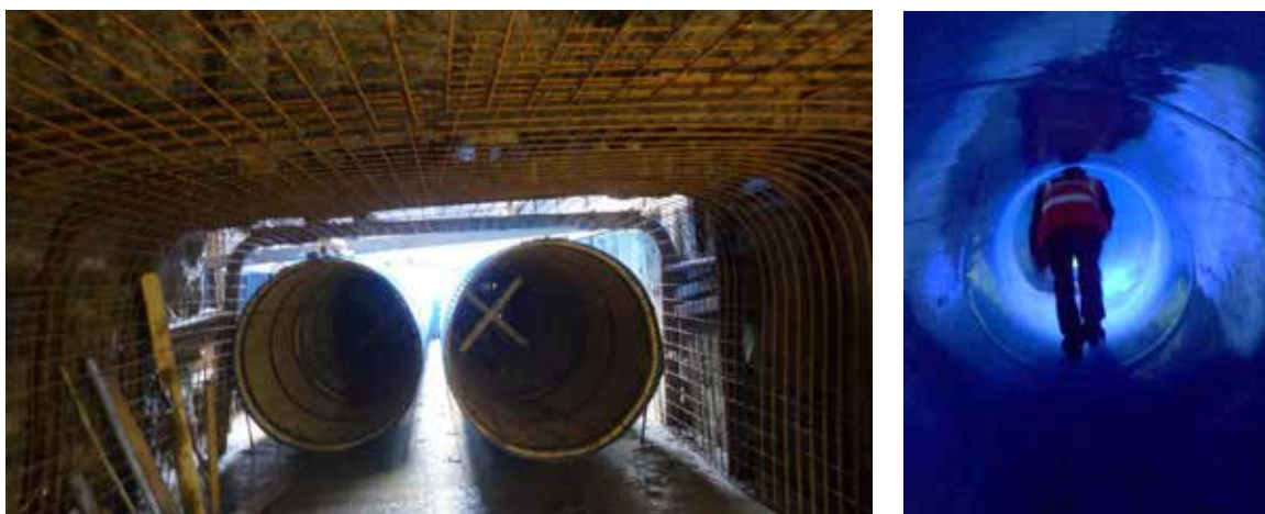
Obrázek 7: Vystýlka štoly Nátokového objektu – montáž do štoly; vnitřek jednoho z kanálů po dokončení
