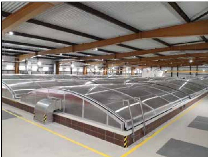
GAU filtrace - zakrytí filtrů polykarbonátovými segmenty
