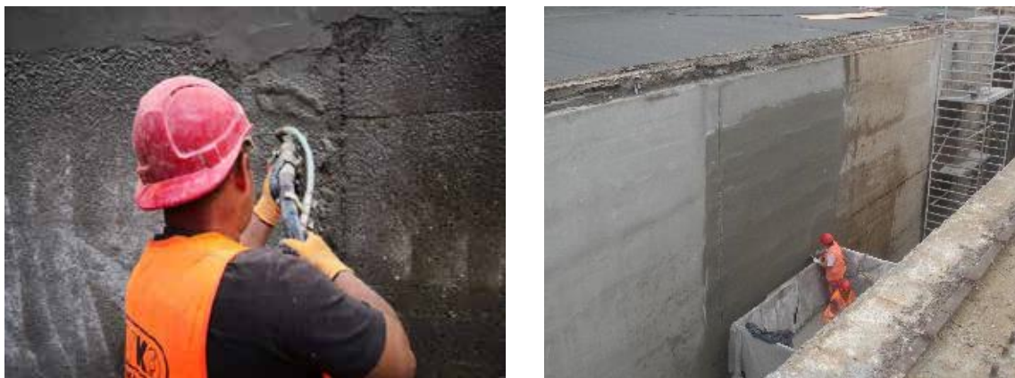
Obrázek 9: Obtokový kanál – nanášení reprofilační malty stříkáním; finální hlazení ocelí
