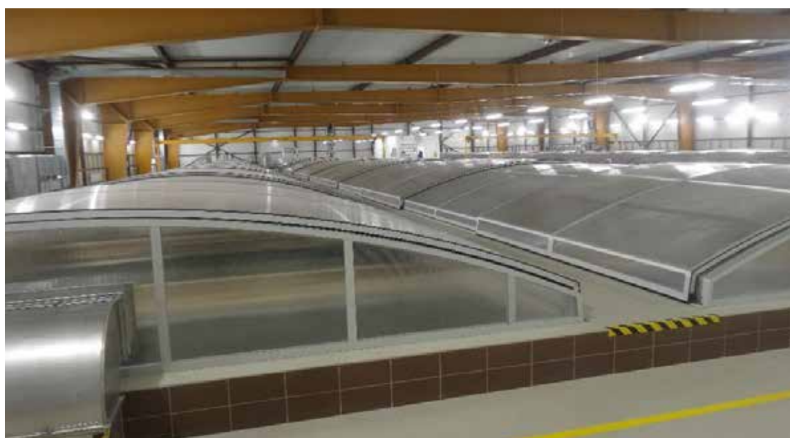
Obrázek 4: Zakrytí filtrů – celkový pohled
