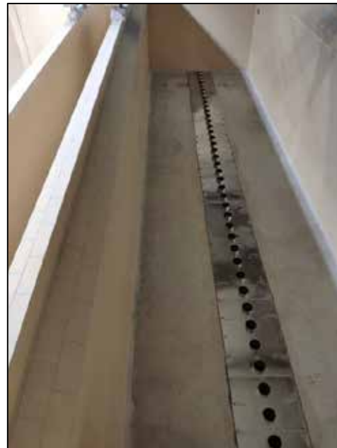
Dno filtru s drenážním systémem (nahore) a distribuční žlab před osazením drenážních větví (vpravo)
