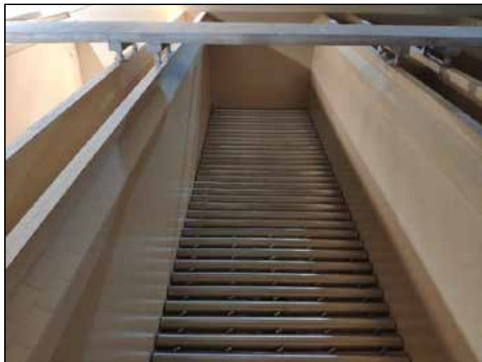
Dno filtru s drenážním systémem (nahore) a distribuční žlab před osazením drenážních větví (vpravo)
