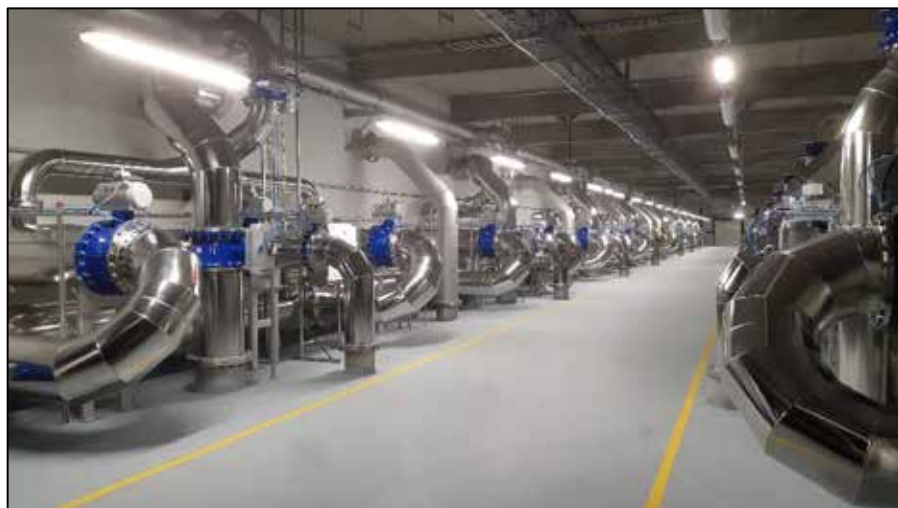
GAU filtrace - středová armaturní chodba s rozvody filtrátu, prací vody a pracího vzduchu
