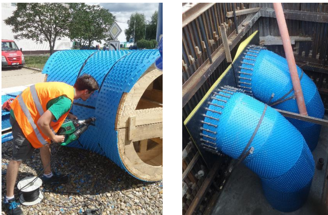
Obrázek 6: Vystýlka spadíšťe – príprava segmentového kolena; finální osazení při betonáži v šachtě
