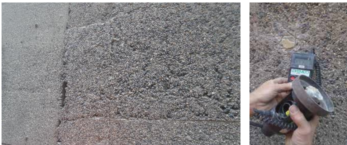
Obrázek 8: Obtokový kanál – stav nekvalitně provedeného betonu; odtrhové zkoušky po preparaci VVP
