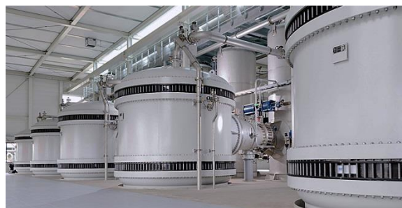
Obr. 2 ÚV Andijk III – mikrofiltračné objekty s keramickou membránou
