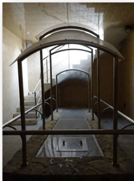
Obr. 2 Úpravňa vody Vajsove Pramene po rekonštrukcii [Foto: autori]
